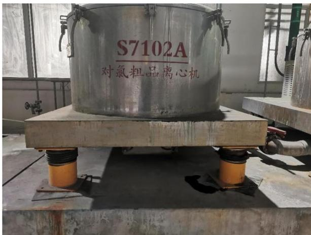
设备减震装置、隔声装置
