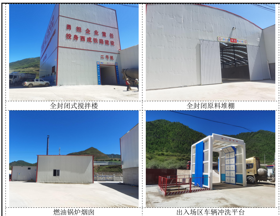
图6 废气治理设施建设情况
