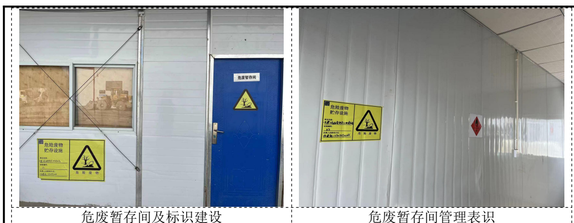
图 7 固废收集及治理设施建设现状
