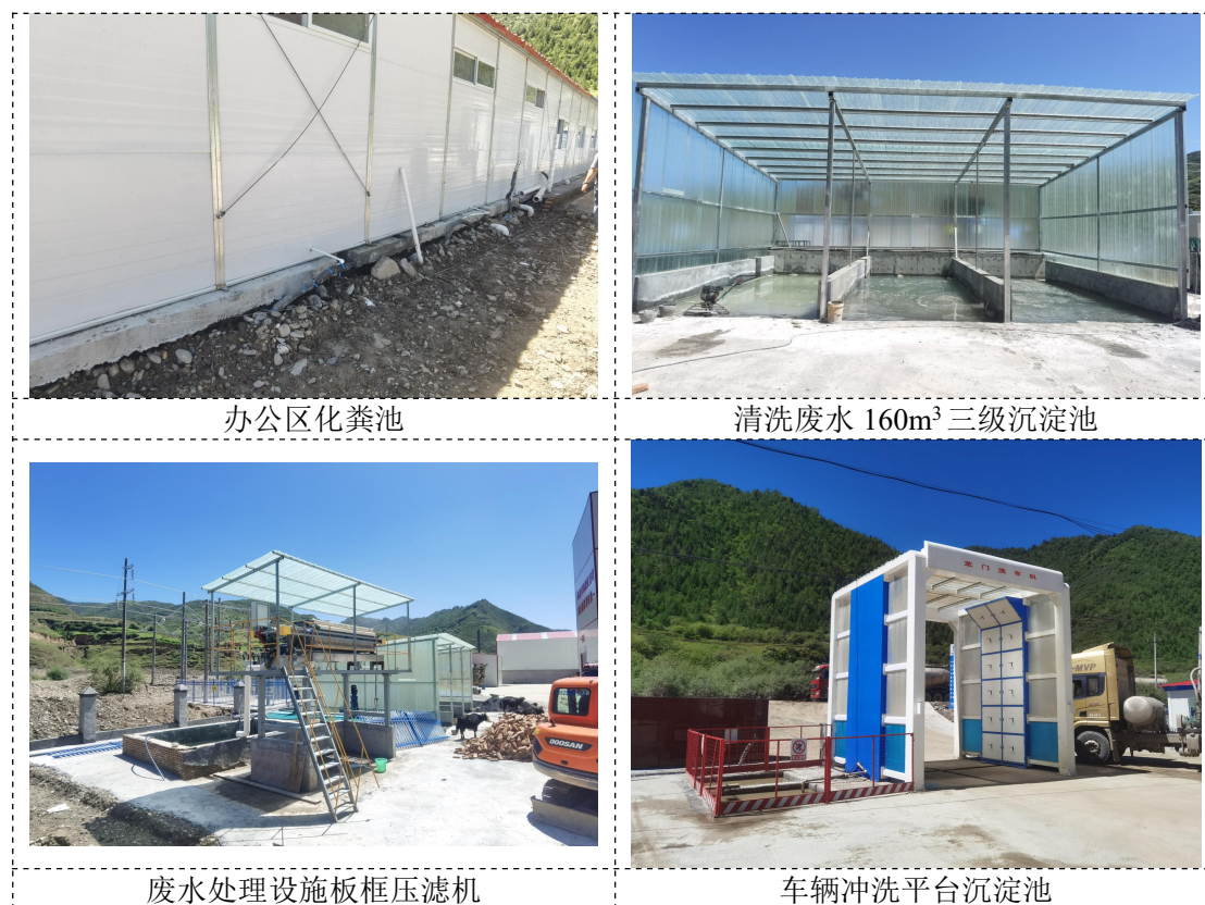
图 5 废水治理设施建设情况
